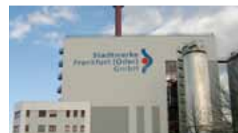
Elektrociepłownia przedsiębiorstwa komunalnego Frankfurt nad Odrą
