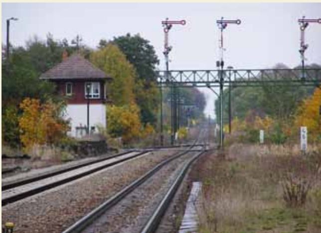
Odcinek Kolei Wschodniej przy Müncheberg
