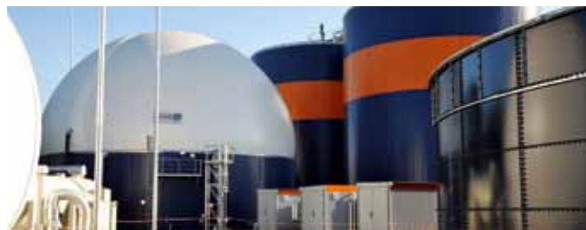
Biogazownia w Ratenow produkuje z surowców odnawialnych około 45 milionów kWh biogazu ziemnego rocznie i wprowadza go do publicznej sieci energetycznej
